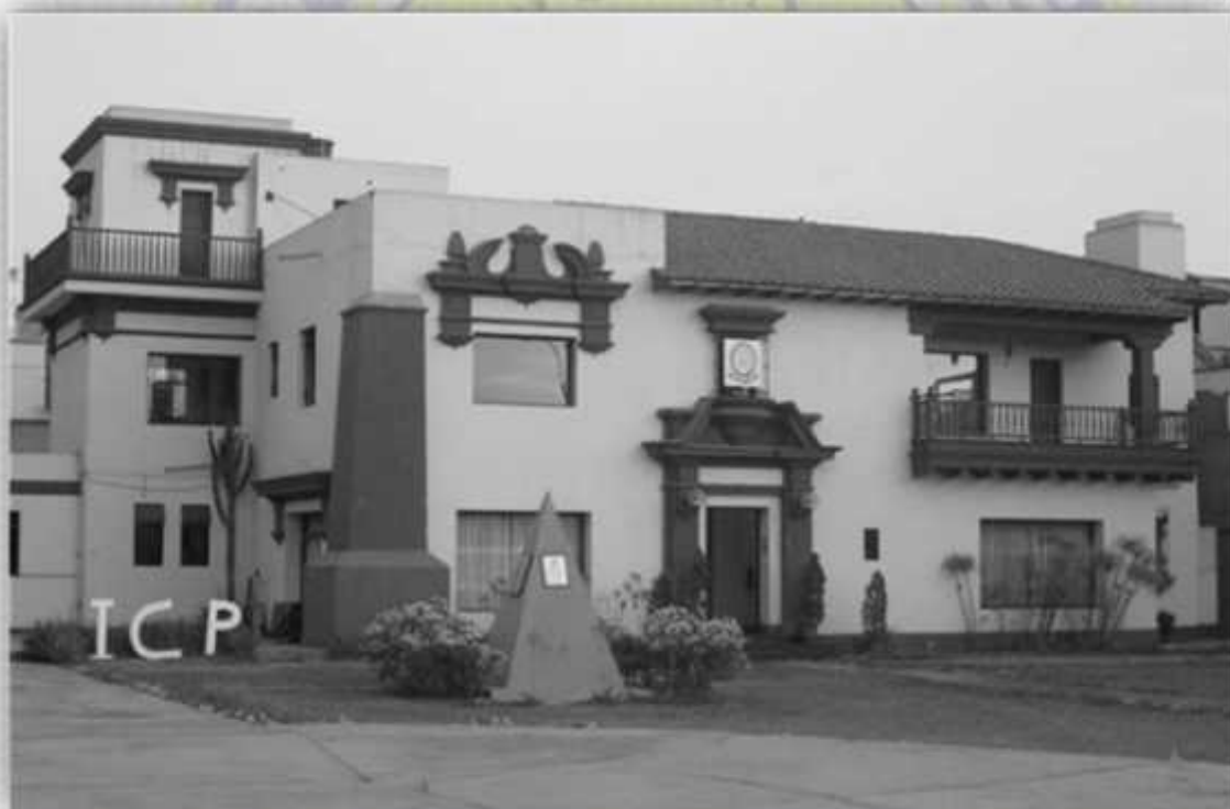
Actual Local del Instituto de Contadores del Perú, ubicado en Av. Brasil N° 1525 Jesús María - Lima
