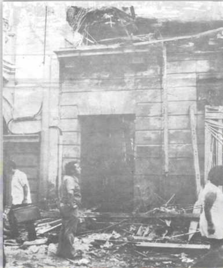
Local Institucional del Jirón Carabaya – Cercado de Lima, completamente destruido
