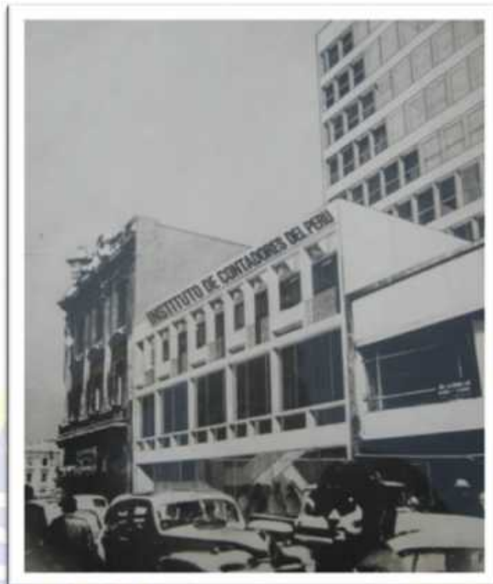
Local Institucional adquirido en 1940, ubicado en Av. Carabaya N° 780 – Cercado de Lima
